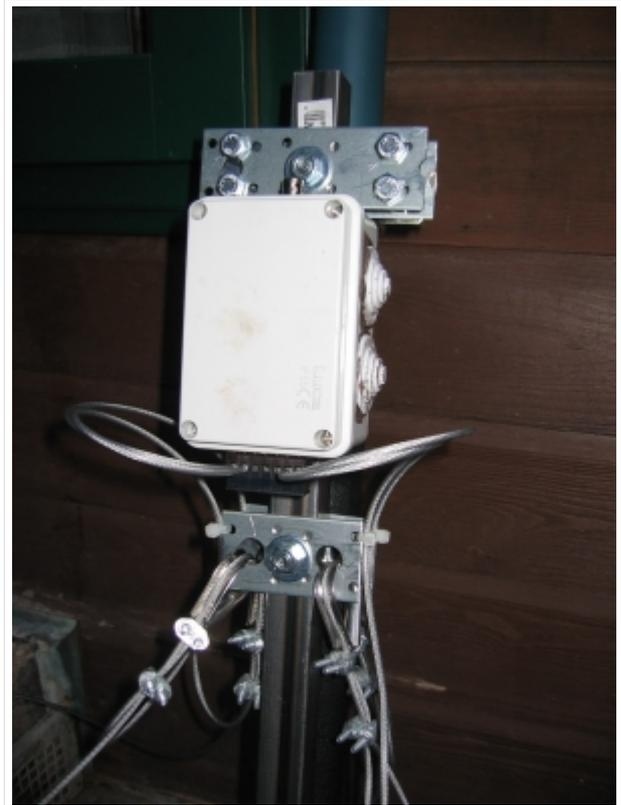
Transformator im geschlossenen Gehäuse
