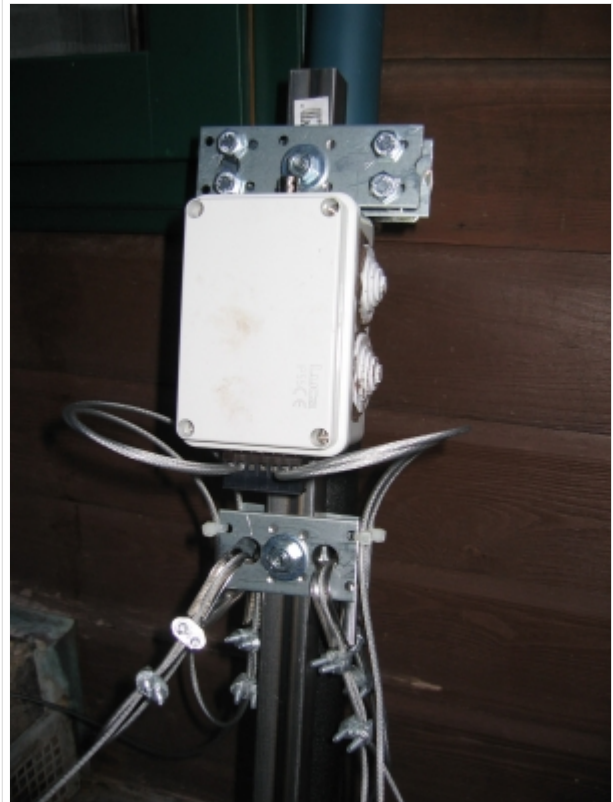
Transformator im geschlossenen Gehäuse
