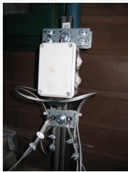
Transformator im geschlossenen Gehäuse
