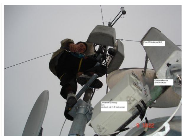
Arbeit am Mast 20m über Grund
