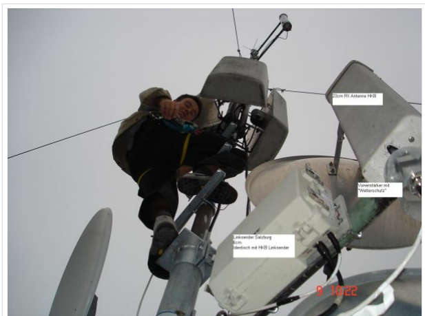
Arbeit am Mast 20m über Grund
