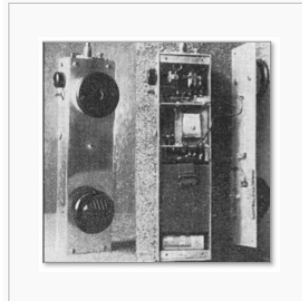
2m Transceiver (Handfunksprechgerät) aus CQ 10/1949 von Bernd Cramer, DL3XC
