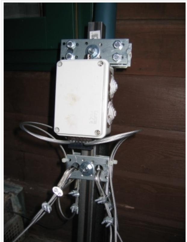
Transformator im geschlossenen Gehäuse
