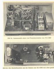
Innenansicht der 2m Transistorstation
