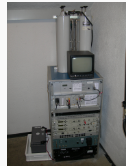
Geräteschrank ATV, darunter OE7XTR 145,775
