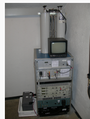
Geräteschrank ATV, darunter OE7XTR 145,775
