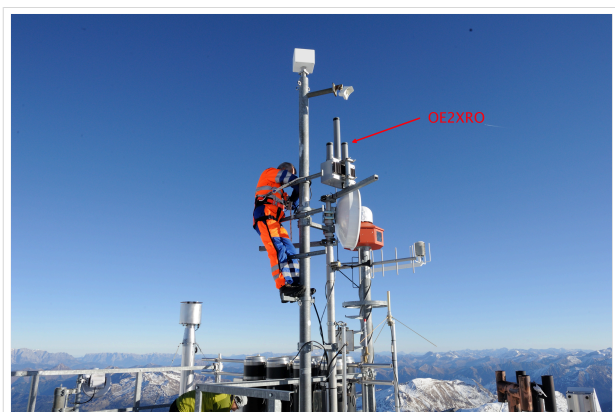
Blick auf die Bake OE2XRO mit 3 Antennen
