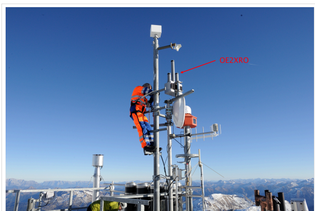
Blick auf die Bake OE2XRO mit 3 Antennen
