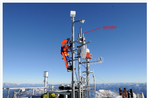
Blick auf die Bake OE2XRO mit 3 Antennen
